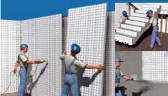
Панель ЕММЕ-М2® может быть легко перенесена вручную одним / двумя работниками, в том числе и в собранном виде и размерами более 4 квадратных метров. В последствии, во время сборки, такая панель может быть обработана и размещена вручную одним работником, без использования подъемной техники. Это упрощает и ускоряет монтаж панелей в любой ситуации. Операции не требуют специальной квалифицированной рабочей силы
